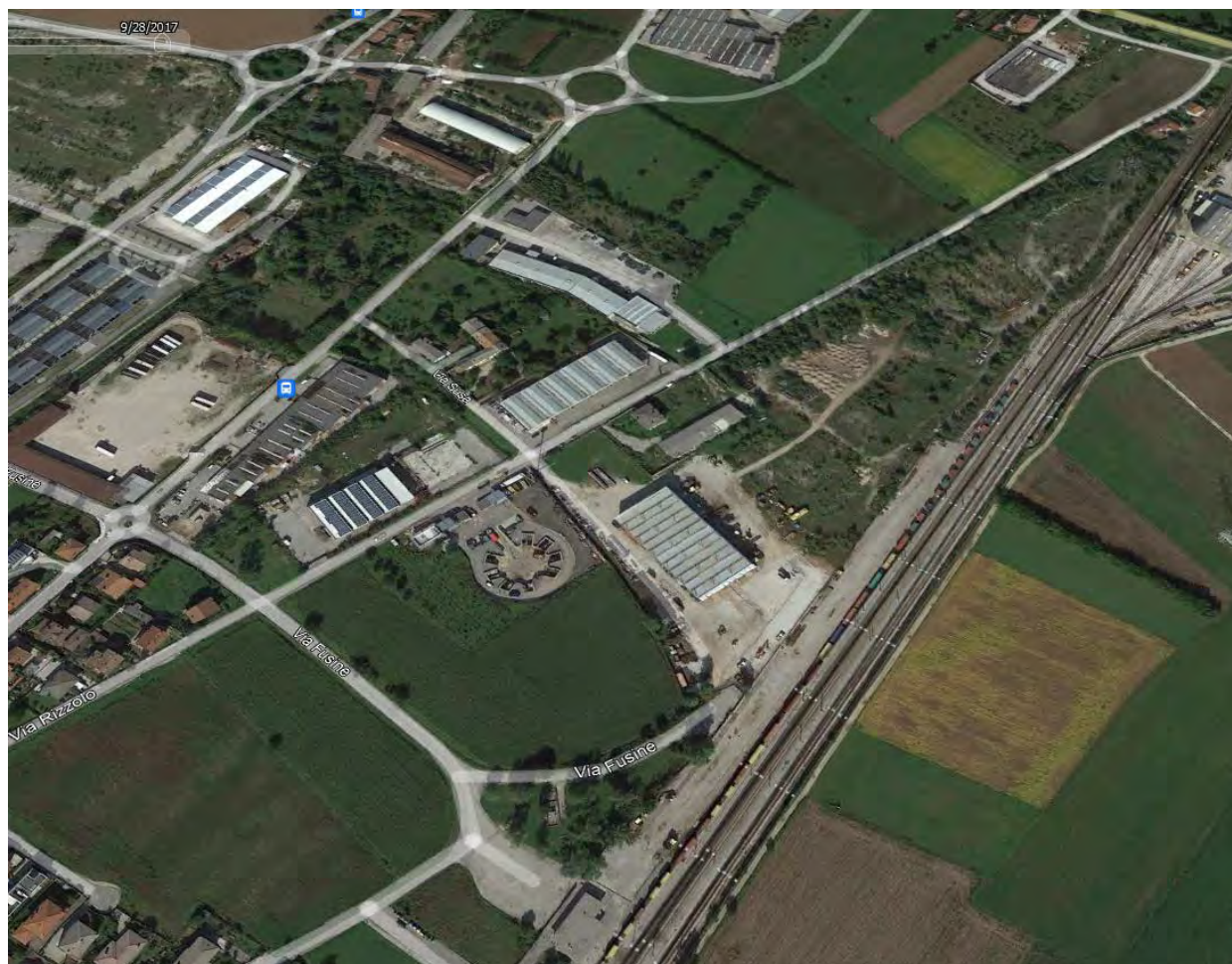
Fig. 44 - Vista da Sud-Est dell'area d'intervento (da Google Earth).
